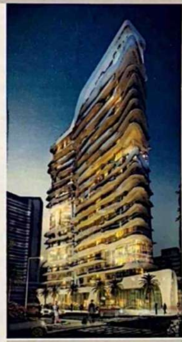
17 Dall'inizio 2016 Recs collabora con ARUP Italia e PLANET IDEA alla definizione del primo sistema di rating per la valutazione di grado smartness applicato alle città in green field
