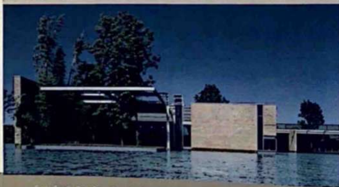
Guido Canali - Sede Olivetti, Gussalla, Poggio Emilia
